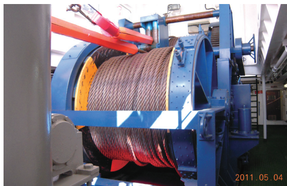
救113號主拖纜機全景
