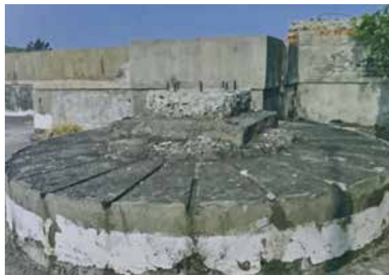
圖 20 位於鎮海樓屋頂的防空機砲基座 資料來源：同註 27，頁 356 附圖
