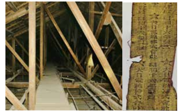
圖 26、27 鎮海樓的臺灣檜木屋樑以及繫留在上 76 年的祈福布條 資料來源：同註 27，頁 357、363 附圖 檢索日期：西元 2021 年 5 月 11 日
